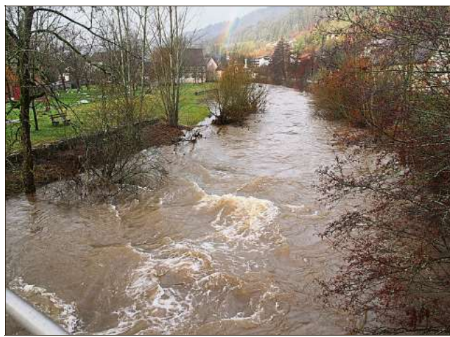
Die Glatt ist angeschwollen, aber nicht übergelaufen. Die Hochwasserschutzmaßnahmen wirken sich aus. Foto: Steinmetz
